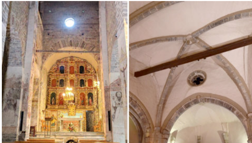
Figura 11. Tensores de madera a) Santa María de Cap d'Aràn de Tredós; b) Sant Joan d'Arties
