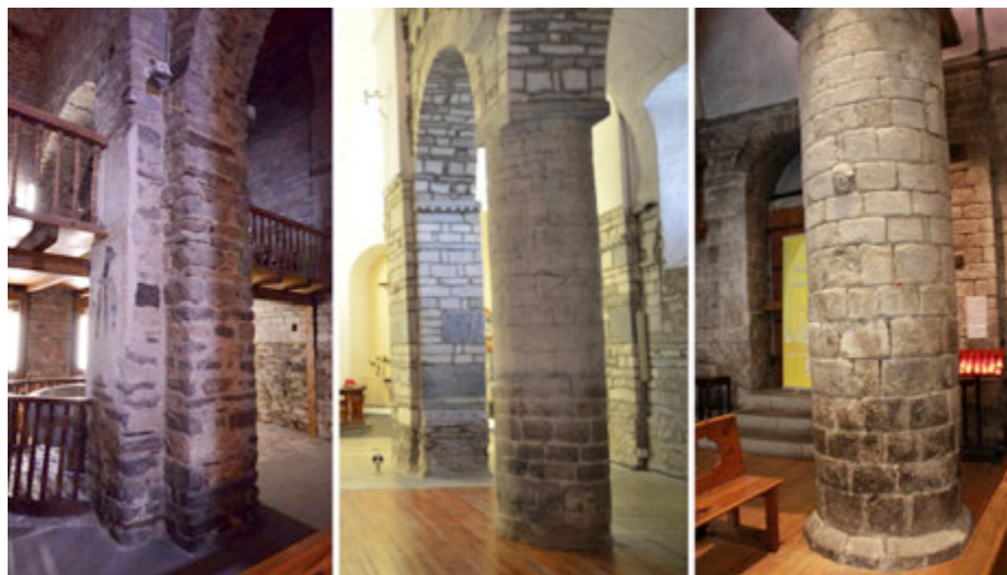
Figura 8. Pilares a) Santa María de Cap d'Aràn de Tredós; b) Sant Félix de Vilà; c) Era Purification de Bossost
